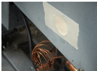
Uszczelnianie przy pianowaniu
